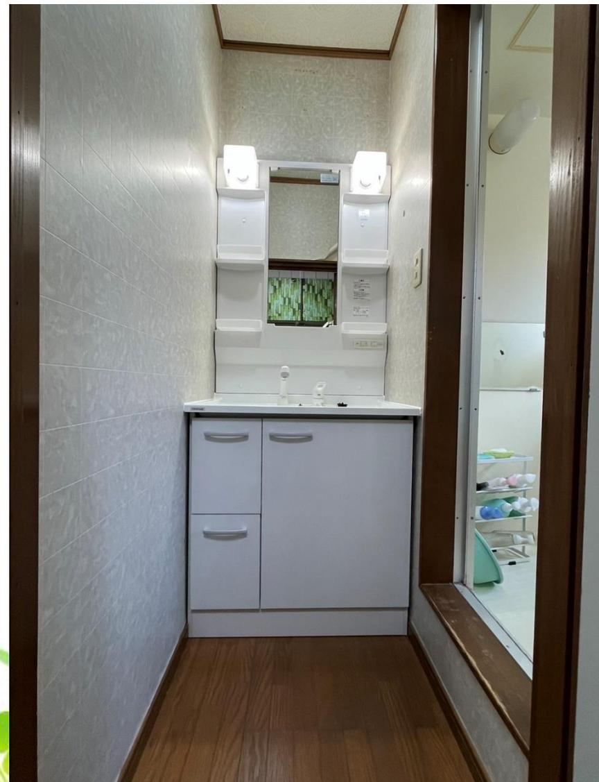
最後、左右の隙間から水が零れ落ちないように、コーキング処理を施しております。
