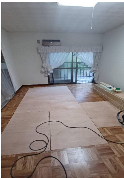
施工中の様子
