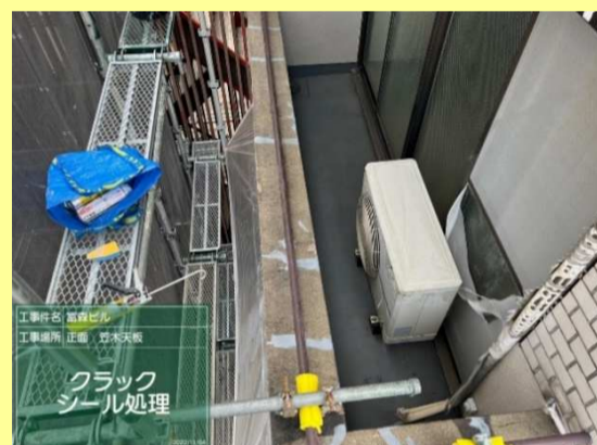
クラック・シール処理
