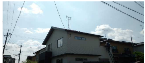
▼アンテナ工事
